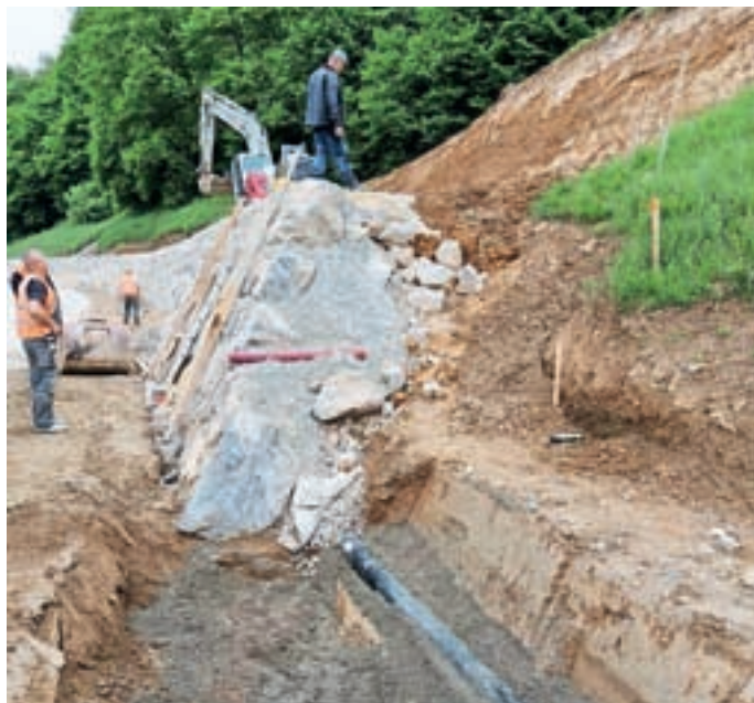
Ob obnovi cestišča nad cesto gradijo kamnito-betonški oporni zid. FOTO: ARHIV OBČINE
