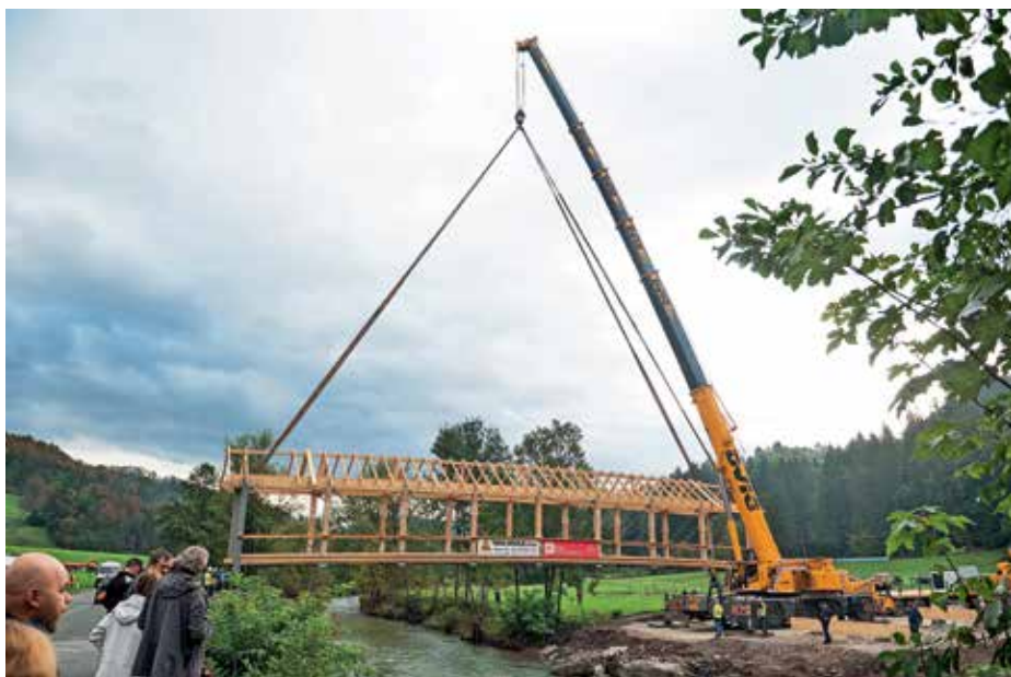
Nameščanje lesene konstrukcije novega mostu je potekalo brez zapletov.
