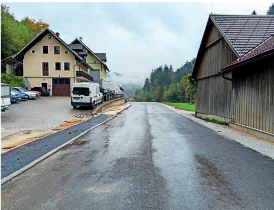
Ne cesti Poljane–Volča so se lotili celovite sanacije prepustov in pripadajoče ceste v dolžini okrog 600 metrov. FOTO: IGOR KRŽIŠNIK
